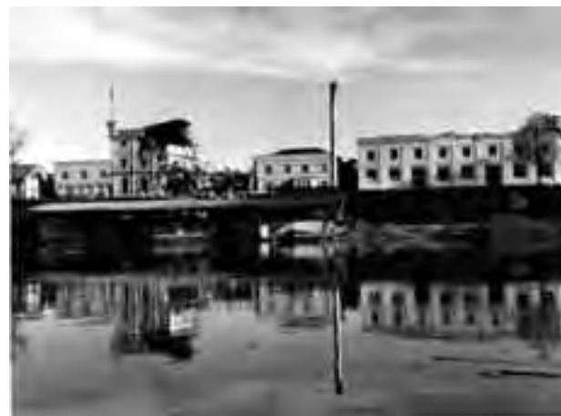
Figura N° 8. Fábrica después del terremoto, 1960.
